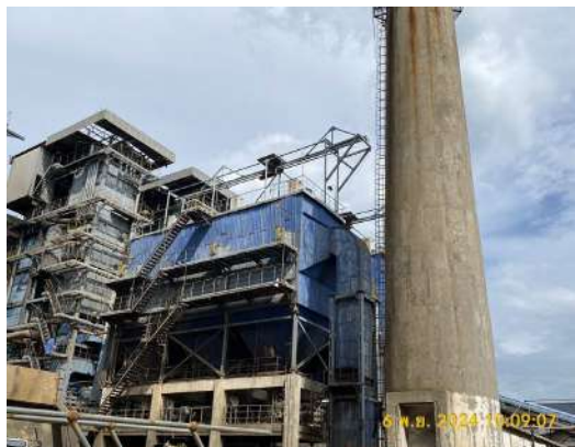
รูปถ่ายที่ 3.2-1 : ระบบดักฝุ่นละอองแบบไฟฟ้าสถิต (ESP) ของหม้อไอน้ำ ขนาด 35 ตัน/ชั่วโมง
