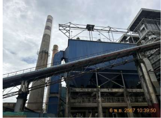
รูปถ่ายที่ 3.2-10 : ระบบสายพานลำเลียงถ่านหินระบบปิด
