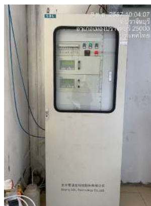
รูปถ่ายที่ 3.2-6 : ระบบตรวจวัดคุณภาพอากาศแบบต่อเนื่อง (CEMS) ปล่องระบายของหม้อไอน้ำขนาด 75 ตัน/ชม.
